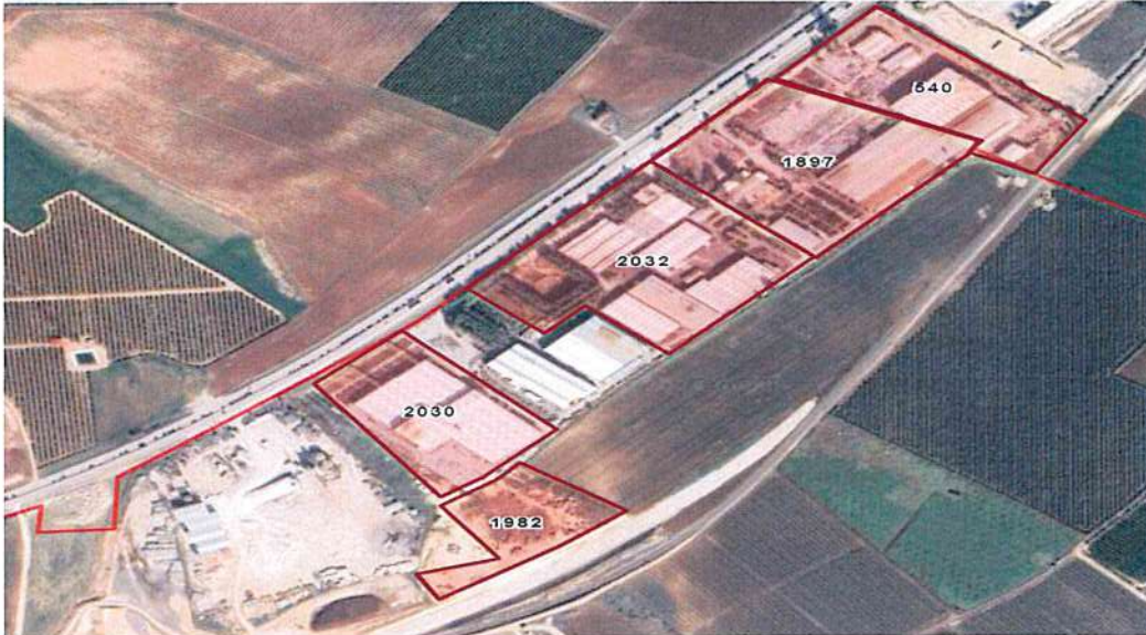
ADANA Yüreğir/ Ceyhan Tesislerinde Yer Alan Taşınmazların Görünümü
