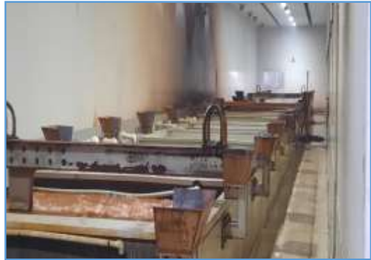
Asit Fosfat Hattı(Havuzlar)-377
